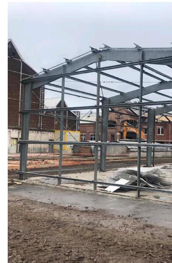
Herstal - Les ACEC - Déconstruction de bâtiments avec récupération de matériaux
