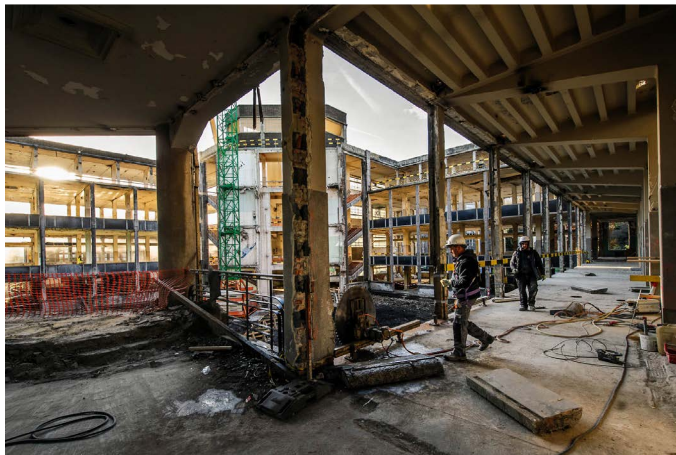
Liège - Val Benoit – réhabilitation du Génie Civil
